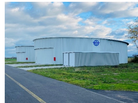
Rundhangar, Vöslau, Wien AUT
