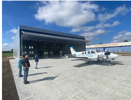
LTB mit Hebefalttor, Donaueschingen
